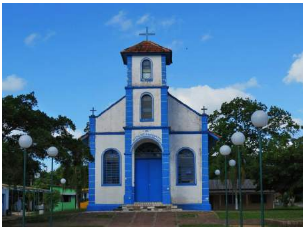
Foto 13: Igreja Nossa senhora dos Navegantes
